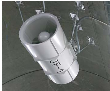
▲軽量型ジェットファン Weight saving type jet fans
