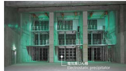
▲電気集じん機 Electrostatic precipitator
