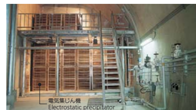
▲電気集じん機 Electrostatic precipitator
