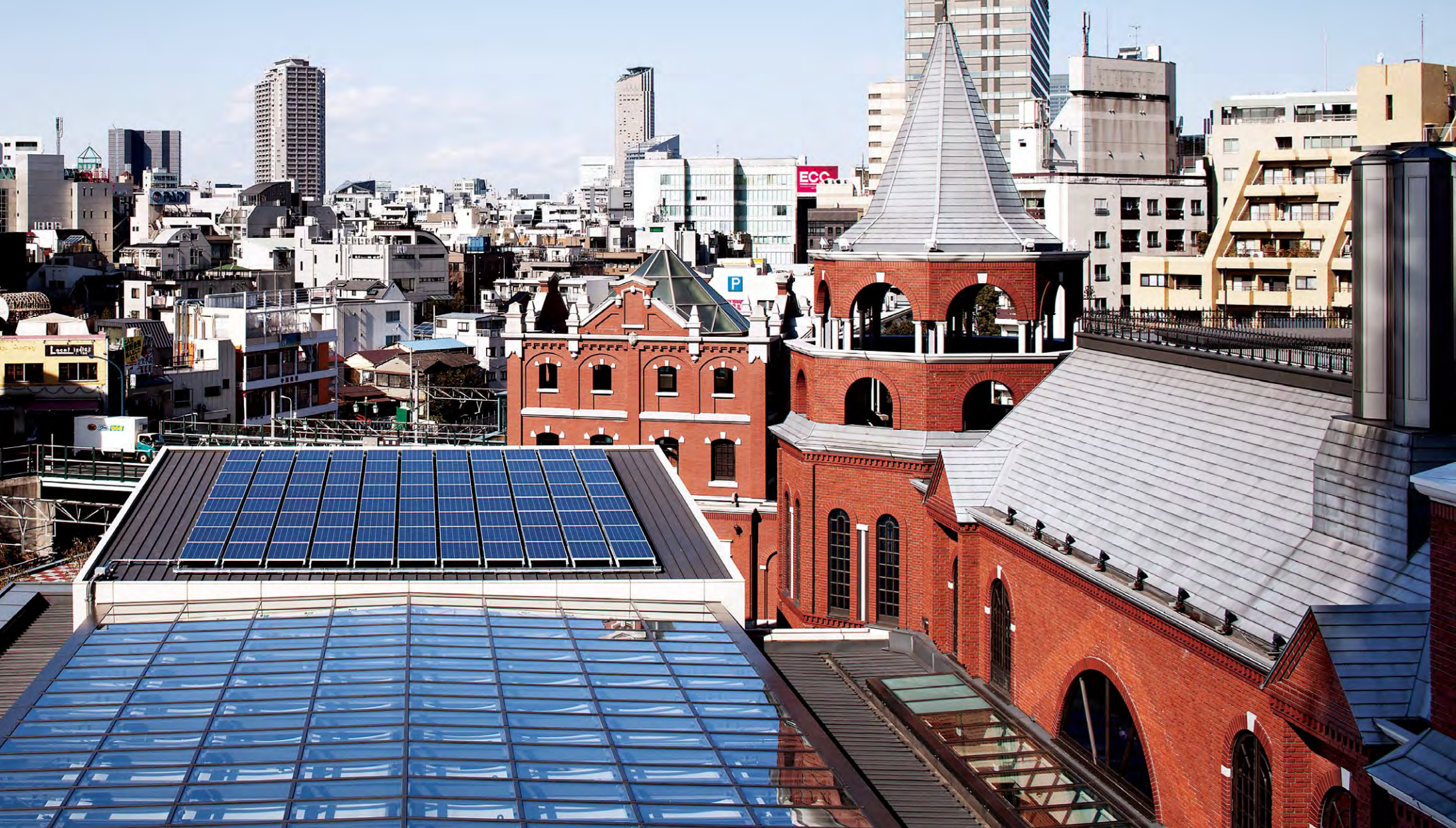
ガラススクエア屋上に設置された太陽電池モジュール
