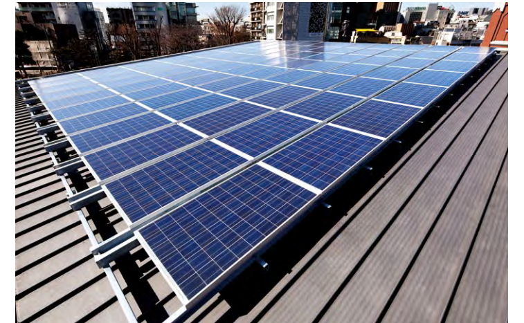
屋上に太陽電池モジュールを88台設置
