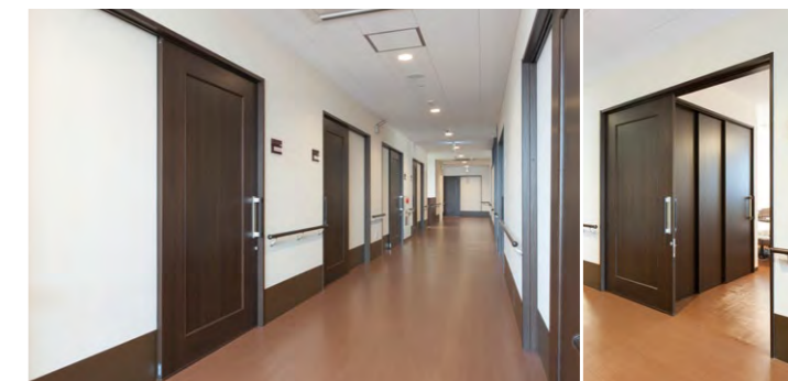
シンプルな動線に沿って各居室が配置され、床面にレールのない上吊り引き戸が採用されている
