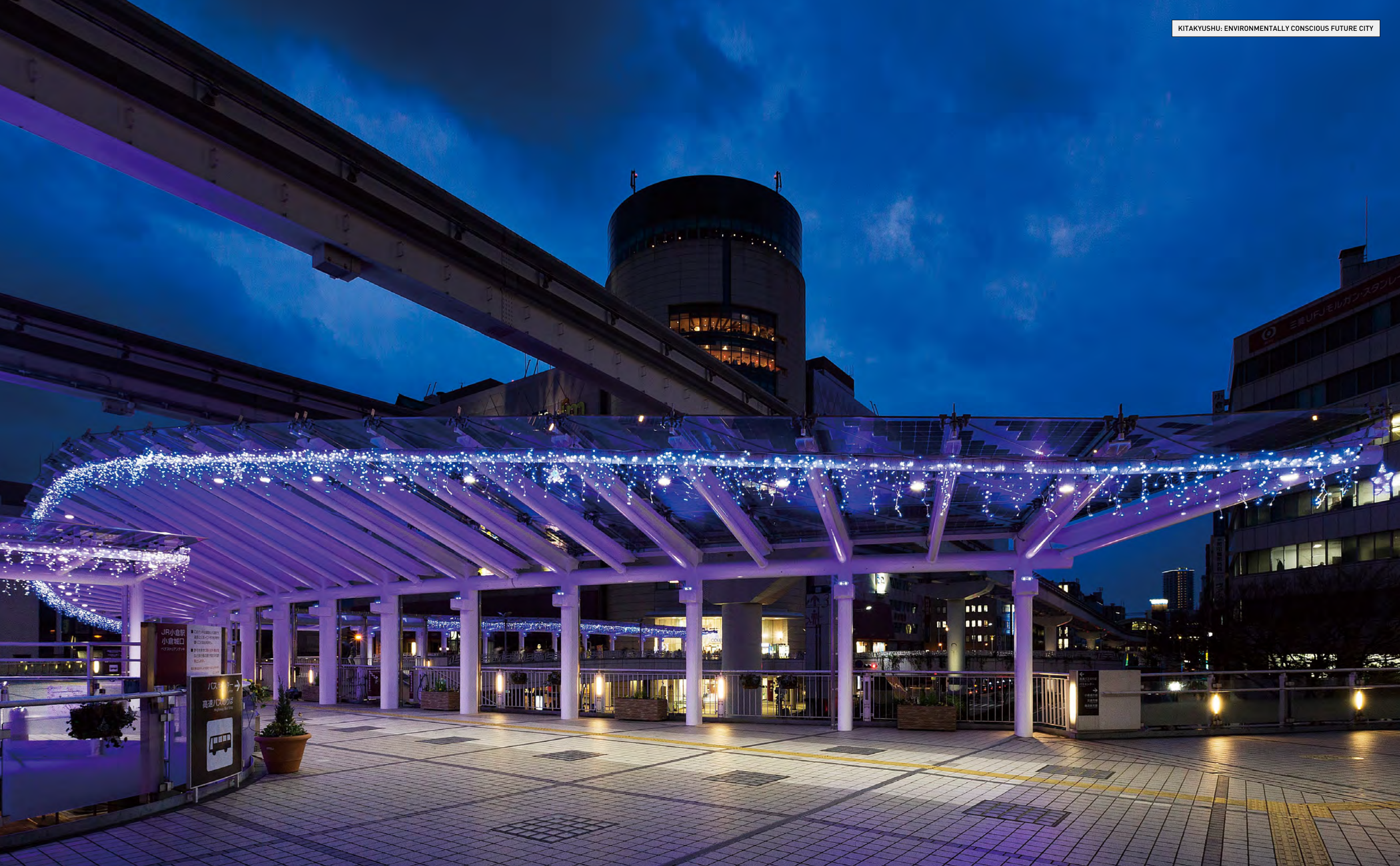
小倉駅小倉城口 ペデストリアンデッキの太陽光発電ループに設置されたLED照明。スポットライトは季節やイベントによって光の色を変化させる ※イルミネーションは株式会社 LEM空間工房のデザインによるもの。別途工事
