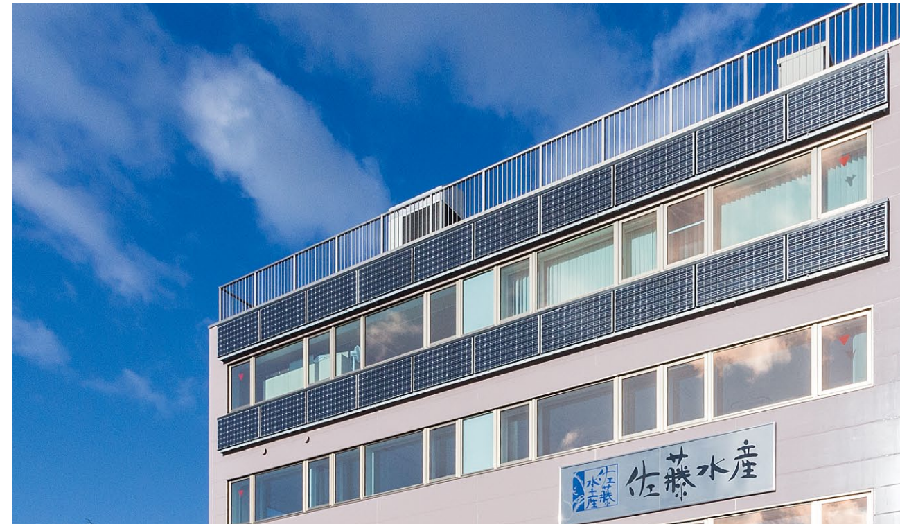
南西と南東の壁面に設置された太陽電池モジュール「HIT215」（写真は南西面）
