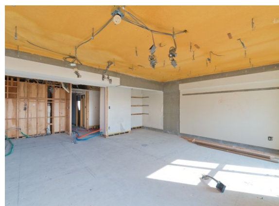
改修前 各部屋の壁を撤去して、アイランドキッチンのスペースを確保
