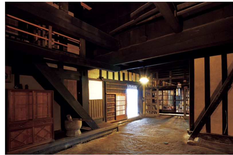
台所からニワ(土間)越しに馬屋が見える。家人は台所の囲炉裏端で来客を迎えたり、ニワで作業したりしながら常に馬の様子をうかがうことができた。馬屋の屋根裏は広い空間になっており飼料や茅を保存した
