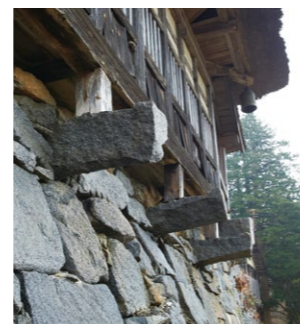
石垣から片持ち梁を出して馬屋を支えている
