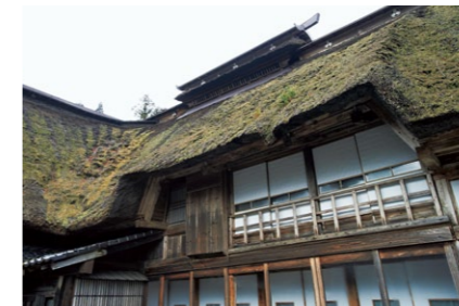
後年、2階を増築したため、採光のために屋根を切り上げてある。他の曲り家には余り見られない珍しい造り
