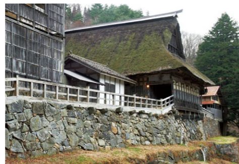
野面積みの石垣に迫り出して建つ馬屋。入母屋造にしたのは破風が人目を引くことを考慮したためともいわれる
