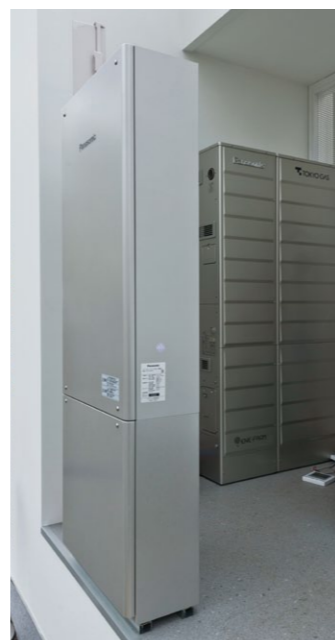
パワーステーションとエネファーム
