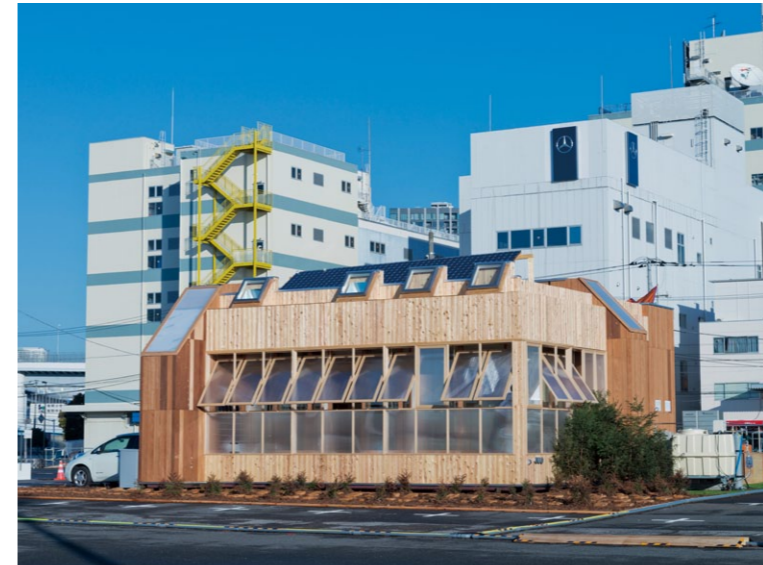
「CUJユニット」が柱のない大空間を構成する
