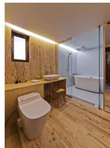
水廻りシェルターに設置されたアラウーノ
