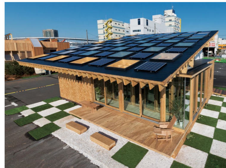
市松状の屋根にはHITハーフタイプが設置されている
