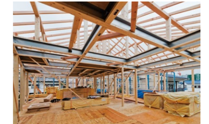
広い梁間が確保された2階保育室
