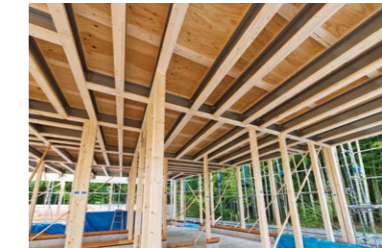
500mmピッチで<テクノビーム>が配置された2階床
