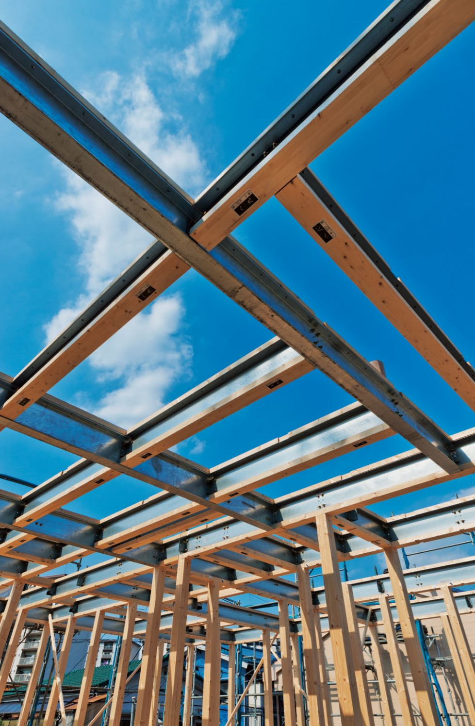
木と鉄の複合梁<テクノビーム>の上に、寄棟造の屋根が組まれている。(写真左は屋根施工前の2階部)
