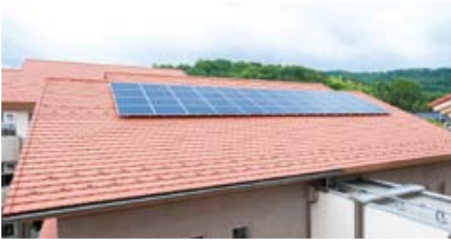
美しい瓦屋根に設置された市立坂西中学校の太陽光パネル
