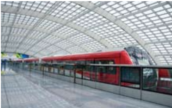
北京市軌道交通首都国際空港線／空調効率を高めるため、低いタイプのプラットフォーム用トラスシステムを採用。CO 2 削減効果にもつながる。
