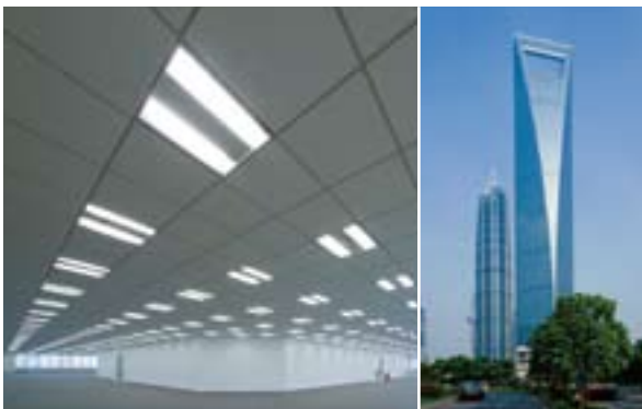
上海環球金融中心／基準階オフィスに配置された24W蛍光灯2灯用T5高出力型照明器具(写真左)と外観(写真右)。
