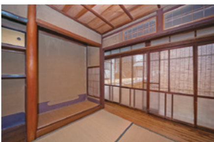
美しい白木を取り戻した床により室内空間は明るい印象に。
