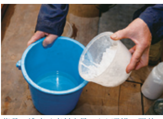
薬品の濃度は素材を見てから現場で調整。
