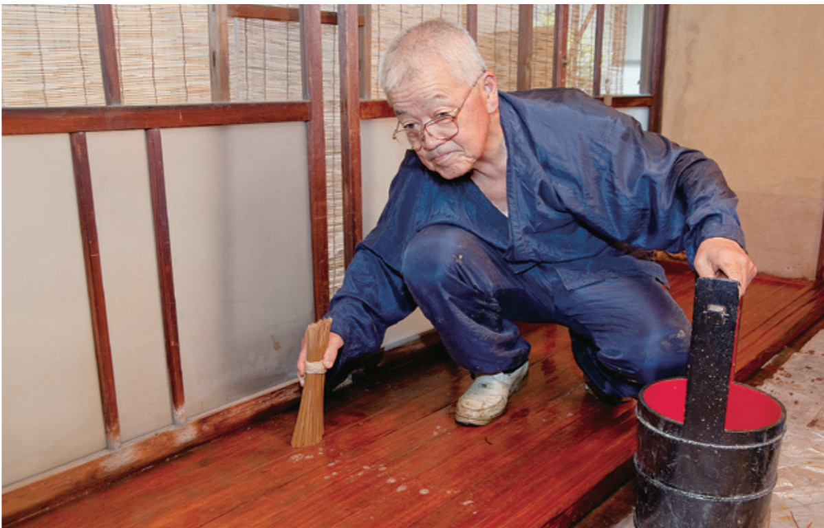
洗い屋の力量が問われる道具「ささら」で、木目に蓄積した汚れをかきだす。(築80余年の京都の町家で)
