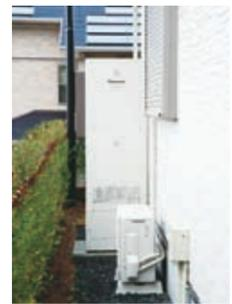
エコキュートは、住宅の設備機器として標準採用されている。
