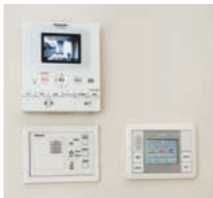
キッチン一角のデスクスペース壁面に設置された「どこでもドアホン」のカラーモニターや電気錠システム、「ライフニティECOマネシステム」のコントロールパネル。
