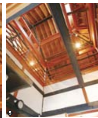
5 台所上部の吹き抜け
