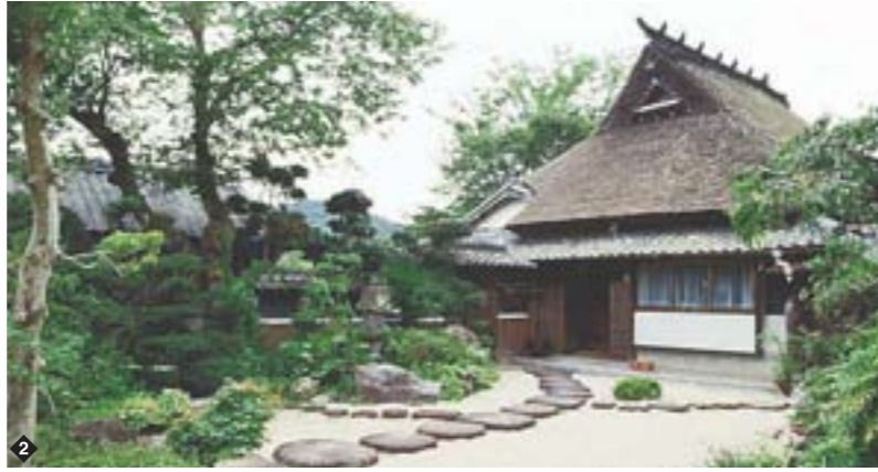
改築前の森脇邸 (写真提供アトリエサワ)
