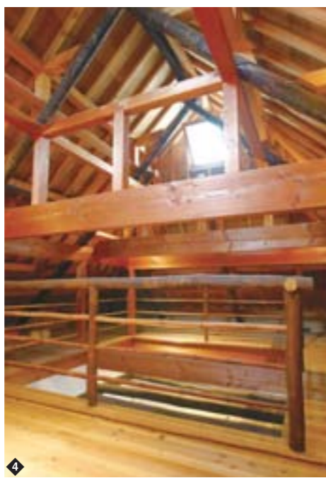
4 ロフトとなった屋根裏。又首組は残したが、新しい屋根材による加重に耐えるように渋柿を塗った新材で母屋・垂木を補強
