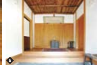
6 玄関の天井には屋根裏に使われていた燻し竹を再利用。その上に漆喰土を置いた
