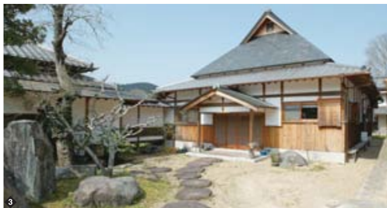
改築後の森脇邸。屋根材は天然スレートに。茅葺きの厚みに似せるため、軒先付近に約3倍のスレートを重ねた。かすかにむくりをつけ、柔らかなシルエットも再現
