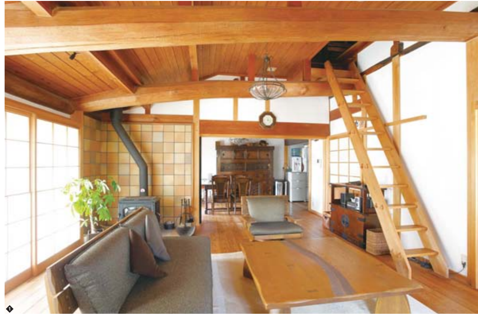
リビングからダイニングを見る。長大な松の梁は洗いをかけて再利用し、あらわしとした。右のはしごから屋根裏のロフトへ
