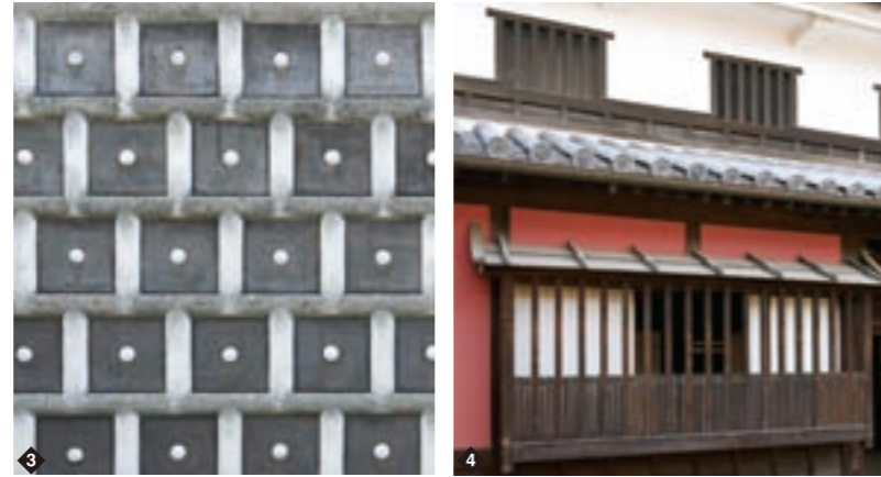
3 四角い目地と丸い釘隠しの漆喰がモダンな柄を描く「なまこ壁」。なまこのような形に漆喰を盛り上げてある 4 長1短3の縦子がデザイン性を感じさせる倉敷格子。下部は目隠しになるように、上部は光が入るように組んである。2階に見えるのが倉敷窓
