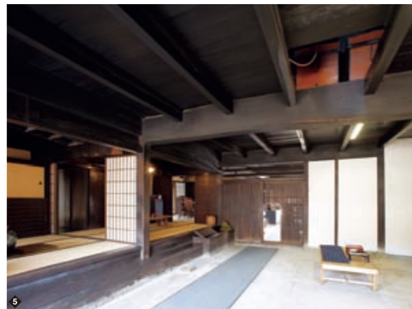
5 時に300もの米俵が積み上げられたという土間。「店の間」は天井を低くし、賊が刀を振り上げられないように工夫した。屋根裏の厨子にはふすまや屏風、食器などを収納した
