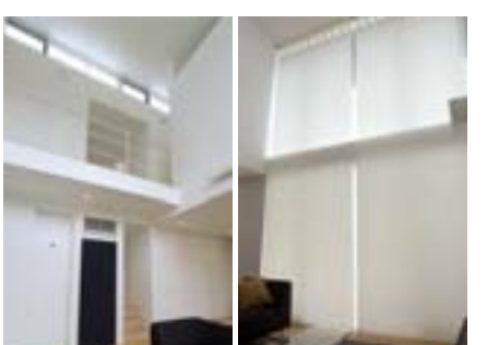
2層分の長さがある大きなロールスクリーン。(右)上部に穴が開けられ、内部に閉じ込めた熱気を対面のハイサイドライトへと逃がす(左)
