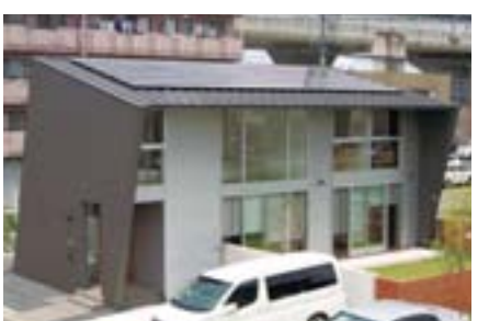
屋根に設置された「パネル裏通気式」の太陽光パネル。屋根はパネルが最も効率的に発電する角度に設定されている
