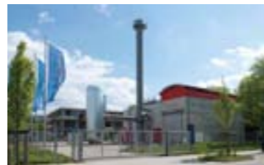
バイオチップを利用したコジェネレーション施設
