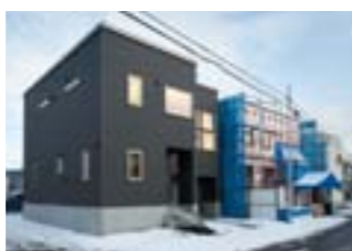
静かな環境の中央区森の宮に 建設中の住まい
