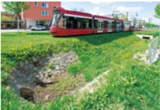
地下水にも配慮した軌道沿いの雨水マス
