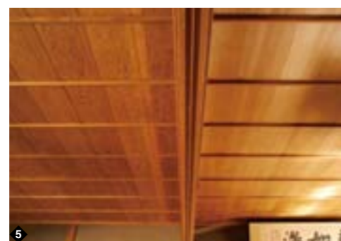
5 右の天井板は杉のまさ目、左は年代物の屋久杉の一枚板。全ての板の色目がそろった貴重な素材を使用
