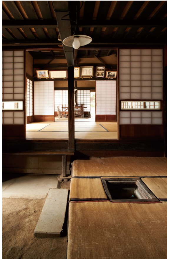
土間からかまどを移設し、炉を切った板敷きの間を設けたり屋根裏部屋をつくりたりして、その時の暮らしに便利ように改築した
