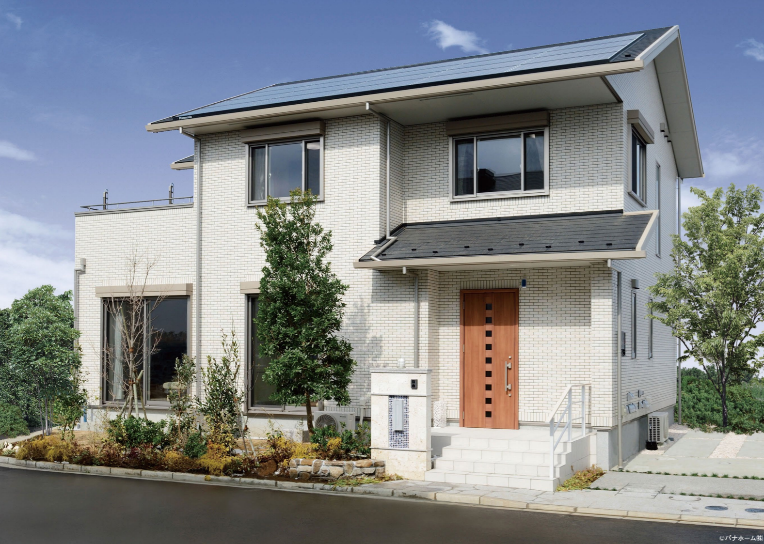
各住戸の屋根には太陽電池モジュールHIT240aを設置
