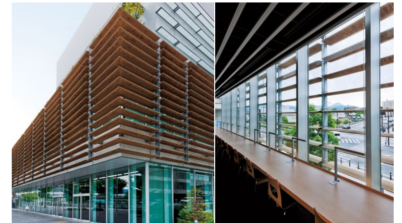
ファサードに設置された再生木の水平ルーバーは直射日光を遮る
