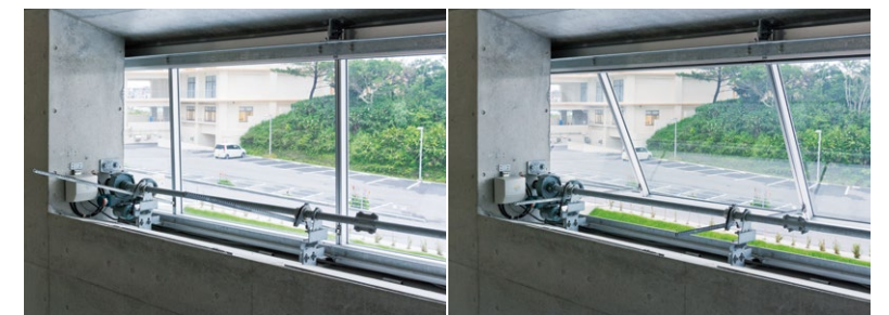
気温、風、降雨センサーと連動して開閉するラック・アンド・ピニオン方式の突出し換気窓
