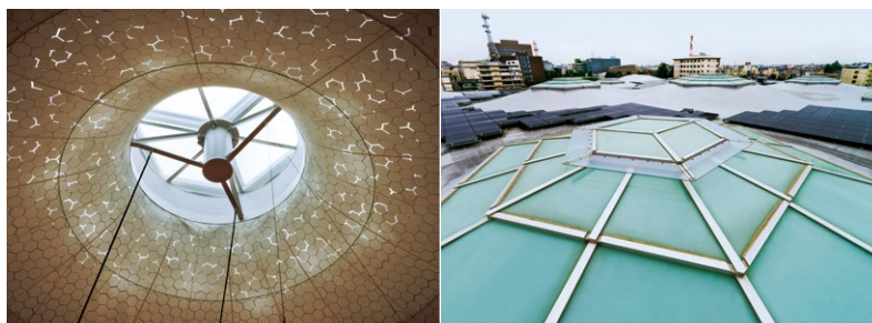
トップライト中央のシリンダーが上下して隙間を作り排気する
