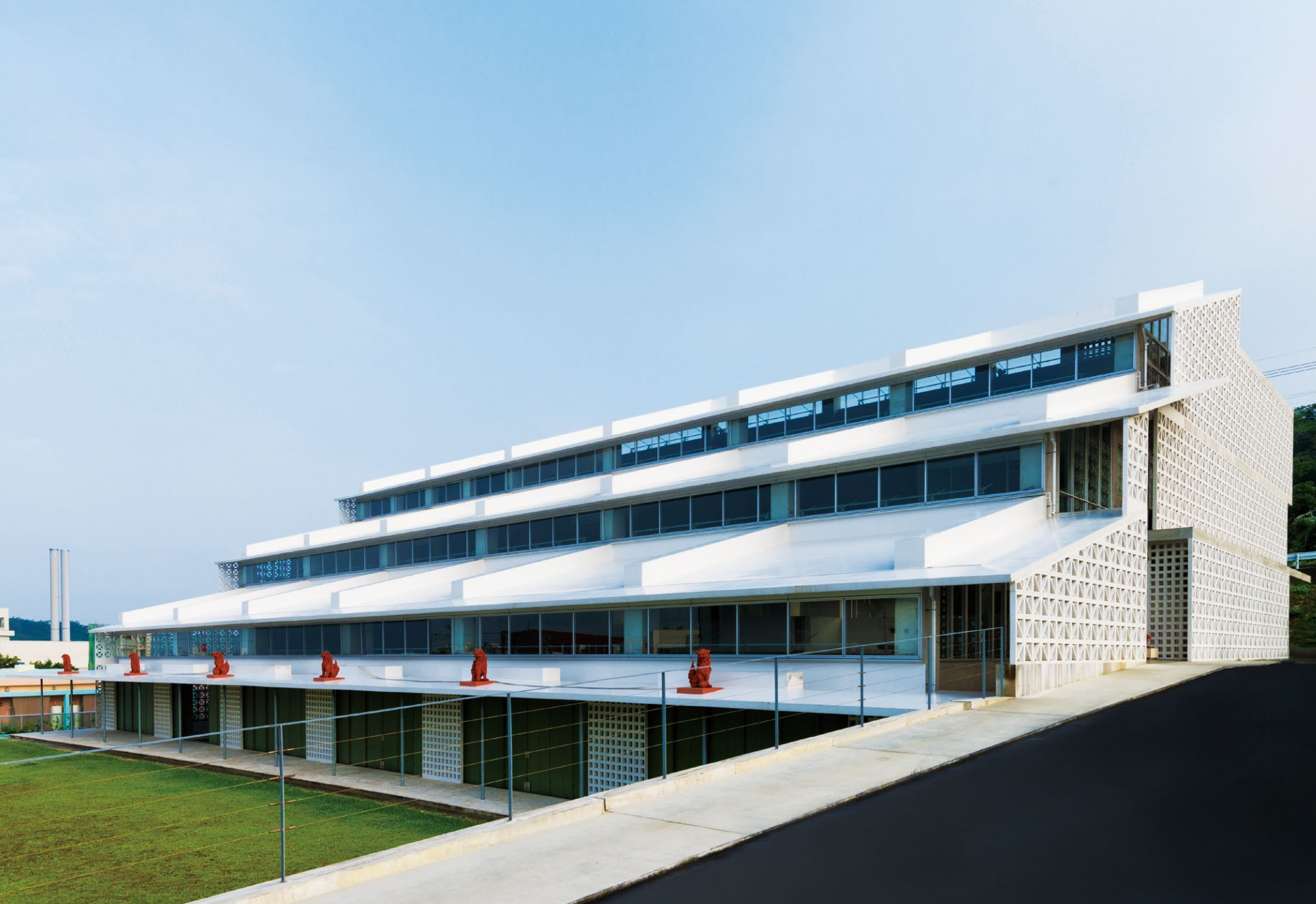
各層の大屋根下に設けられた開閉式の換気窓は存在感を消すために細いフレームが用いられている
