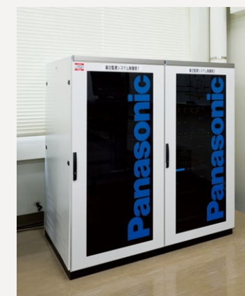
センサ機器の制御サーバが納められたラック
