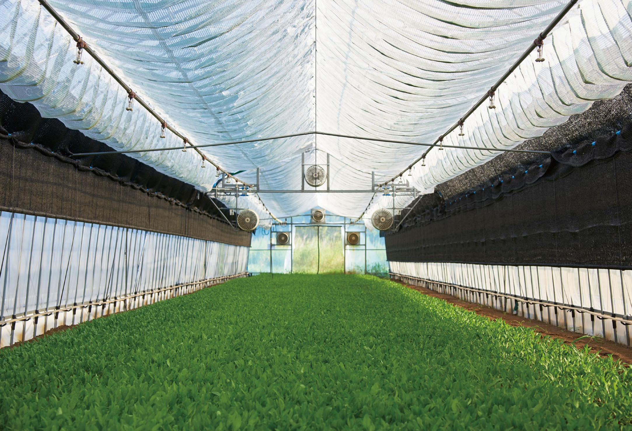
天井・側カーテンにより「太陽光」、側窓と気流調整ファンにより「風」、ミスト・散水により「水」、ハウス内環境を自動制御するパッシブハウス型農業システム
