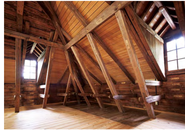
豪壮な骨組みの中央棟小屋裏。腰壁は広い空間を生み出したが、構造上の必要性からではなくドイツ風意匠を取り入れるために採用されたという。
