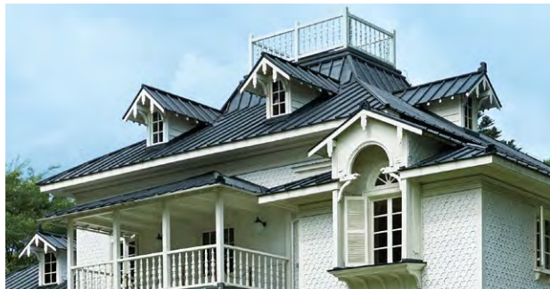
マンサード風屋根やドーマー窓が西洋建築独特の外観を形成している。付属棟2階の妻壁と窓飾りを一体化した窓にも松ヶ崎がドイツで習得した技術が生かされている。
