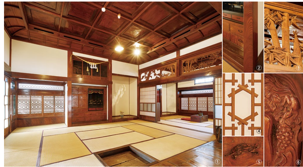
① 樺の間の異名を持つ主人居間。折り上げ額縁格天井には樺の一枚板がはめ込まれている。② 出世奎と呼ばれる上向きの杢目がある樺の床柱、③ 松竹梅（欄間）、④ 亀甲紋（格子戸）、⑤ 亀（家族居間書院棚）、⑥ 豊穡を表すリス（同、書院柱）の縁起物。
