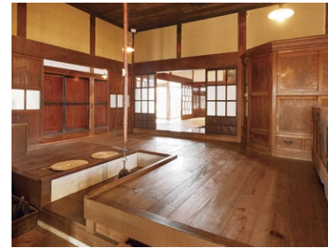
居住棟炊事場には、火や水に強い栗の材木を使用。奥の囲炉裏端へは履物のまま行ける。
