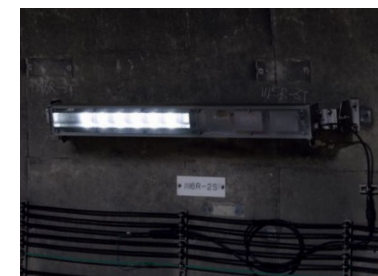
点滅制御で入口部の明るさを確保する入口照明器具
