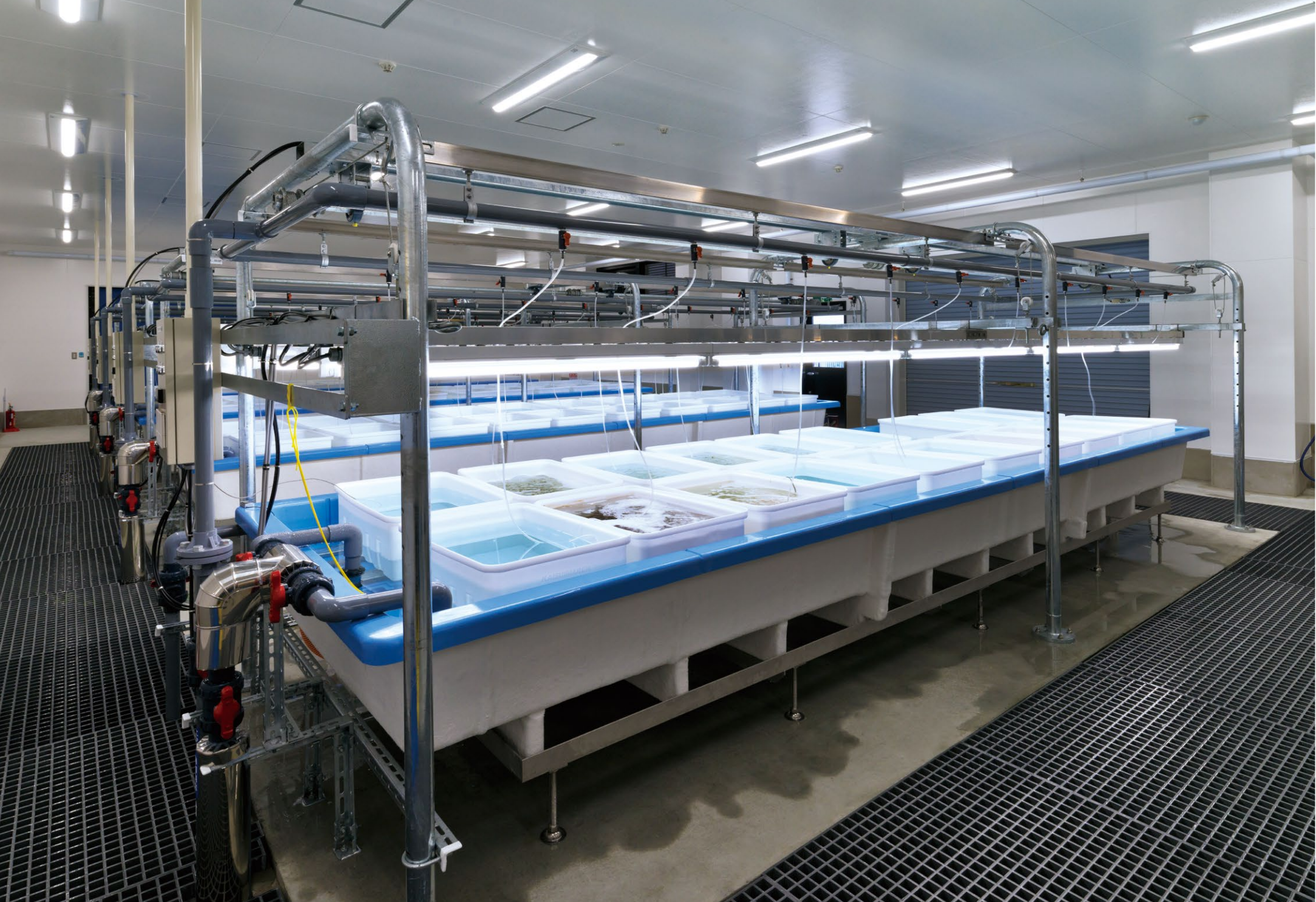
わかめの種苗生育の最適条件を探る種苗室の海水プラント。調光（光色・光量）やスケジュール点灯により、照明環境を自在に変えることができる
