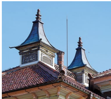
大棟の反り屋根を持つ大型ランタンと煙突。いずれも装飾で本来の機能を果たしていない。
