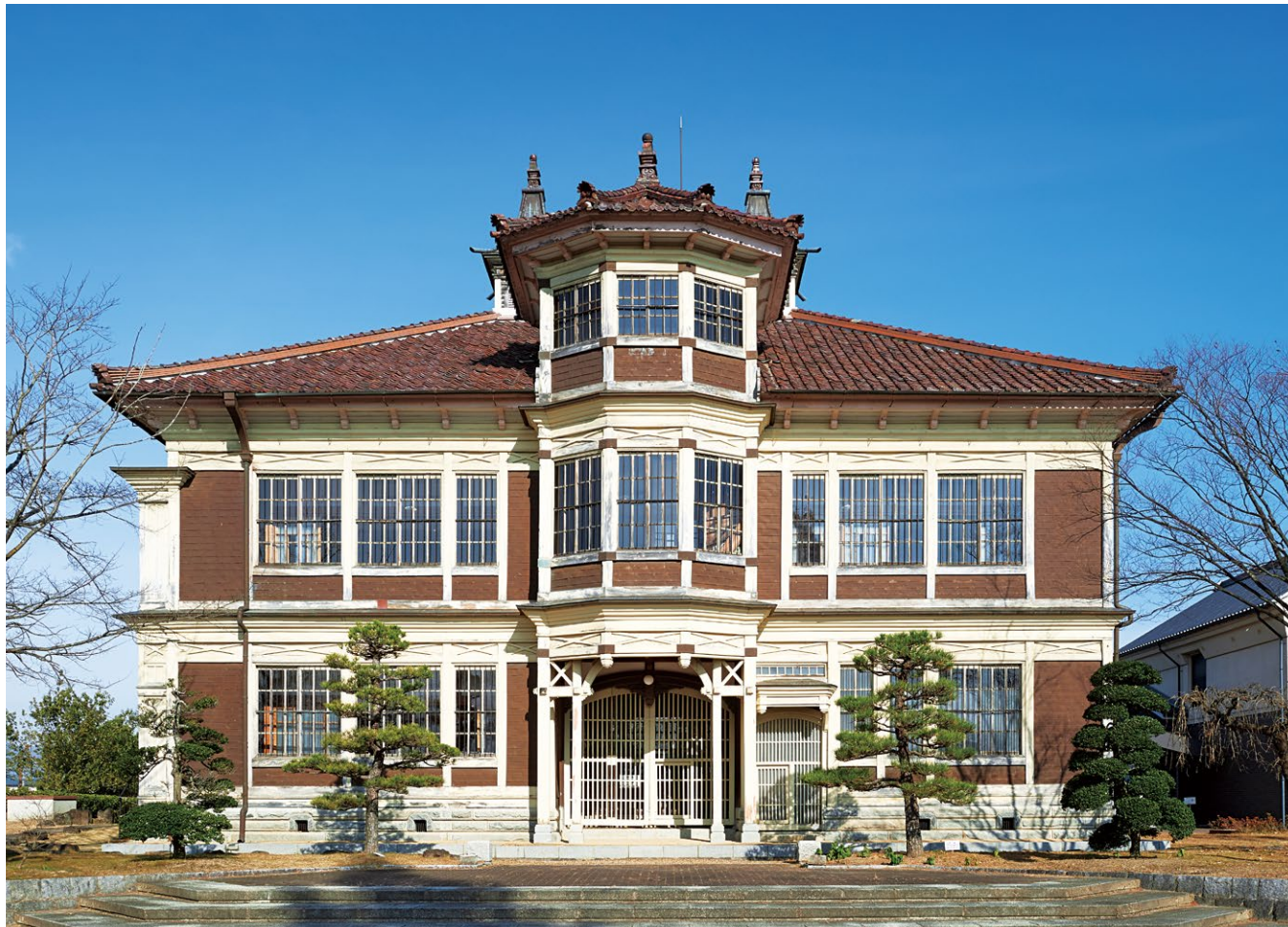
旧亀岡家住宅は洋風の外観に和風空間を内包する擬洋風建築。亀岡正元は西洋建築に憧れ、研究していたとされる。小壁にある筋交い状の飾りは設計者・江川三郎八特有のデザイン。
