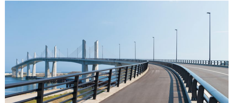
大型船が通航可能な海面高度が確保されたPCエクストラードスド橋
