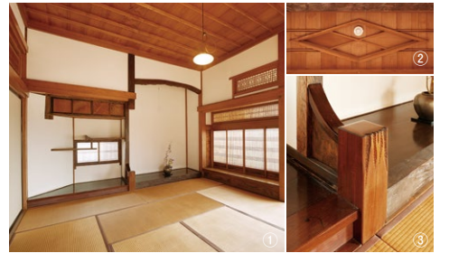
① 2階東座敷。床框の鉄刀木、違い棚の黒柿など、希少な銘木を使用している。② 床の間天井の細工③ 鼓張りにした床柱。
