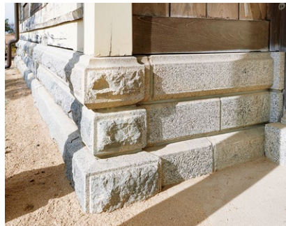
御影石の基礎。瓦葺で重厚な建物を支える土台は玉石を敷き、土つきをした後、3年ほど寝かしたとされる。
