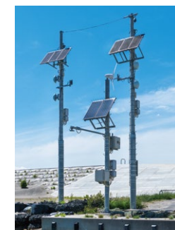
沿岸津波監視システムの機能を強化した浜市中継局
