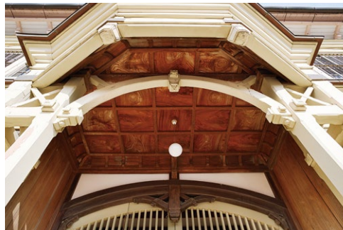
正面玄関。和風の折り上げ格天井を洋風のアーチが支持するユニークな構造。観音開きの木製格子戸もアーチ型で統一。
