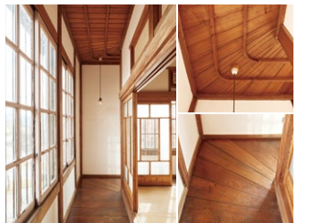
2階廊下の床と天井は「行き止まり」を嫌い、角で板を扇型に並べて縁起をかついでいる。
