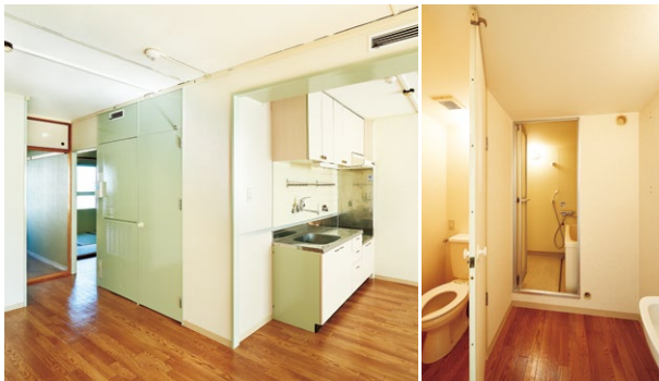
台所の背面に洗面・トイレ・浴室が集約されている。こうした設備ユニットを一括して工場生産した。(兵庫県住宅供給公社賃貸住宅の例)
