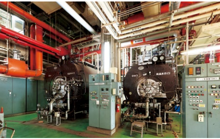
地域エネルギープラントで集中的に高温水を作り各戸に熱を供給する。防災の観点から地域暖房給湯システムが採用された。
