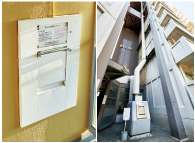
真空ゴミ収集システム。共用階と1階にゴミ投入口があり、処理場までの搬送パイプは地下を通っている。
