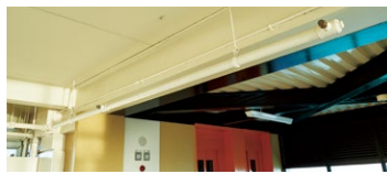
防火設備の一つ・ドレンチャー。住宅に設置したのは当時としては先進的な試み。
