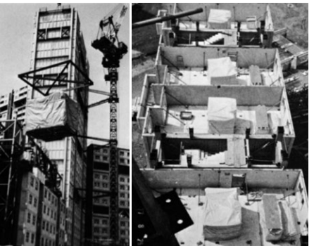
PCa板の床・壁を組み上げた所へ、設備ユニットなどを揚重、搬入し、次の階の床を取り付けた後、内装を仕上げた。画像提供: 株式会社アステム
