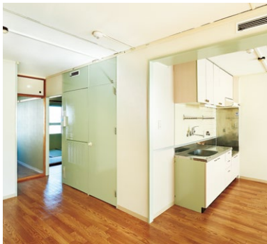
台所の背面に洗面・トイレ・浴室が集約されている。こうした設備ユニットを一括して工場生産した。(兵庫県住宅供給公社賃貸住宅の例)
