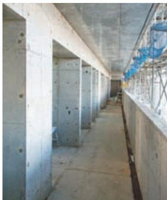
コンクリートが固まった後のフロア。
