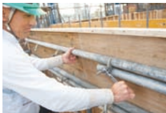
写真上/変形と破壊を防ぐため、梁側の型枠を抑える鉄パイプを固定する。写真下/数値を見て誤差をなくすため、垂直の精度を測る下げ振り。
