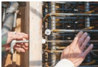
写真上/コンクリートの圧力を考え、左手のフォームタイでコンパネを調整する。写真下/型枠と鉄筋に適切な距離を保つため、鉄筋にドーナツ(プラスチックの輪)を取り付ける。
