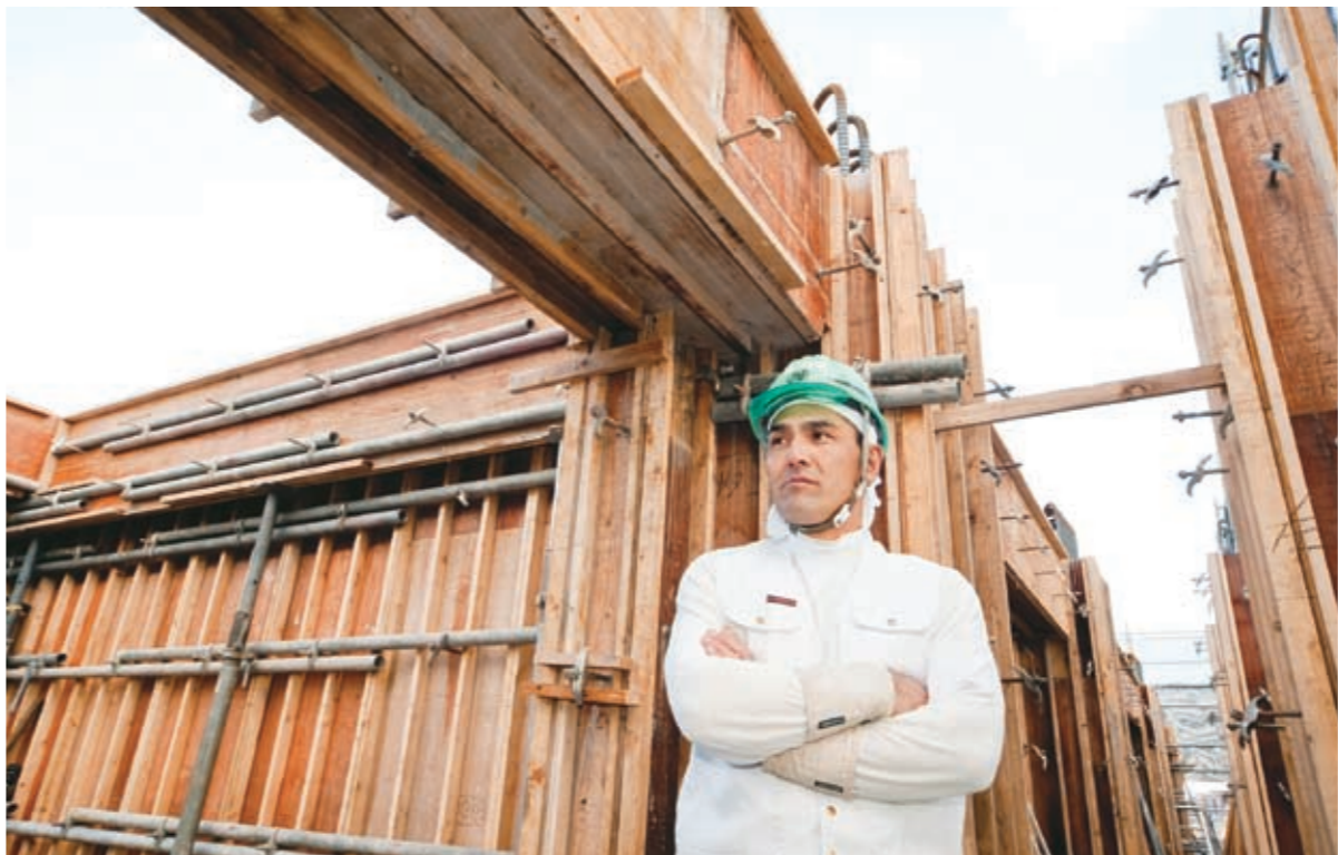
「どんな型枠でもゆがみのない精度の高い仕事が命」と語る川畑さん。(東京都板橋区、京王建設株式会社様の賃貸マンション建設現場で)
