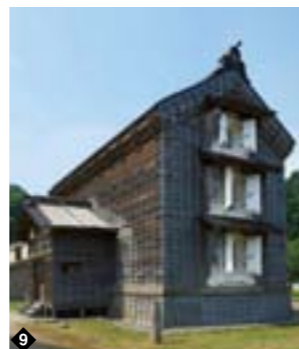
9 3層の文書庫。漆喰の壁を板で覆い、潮風による劣化を防いだ
