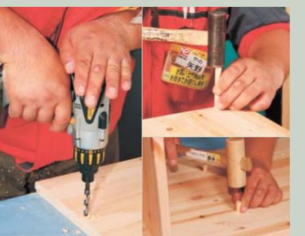
5 本体の箱の部分(側板・天板・底板)をダボ処理で組み立てる。マルチインパクトドライバーの木工用ビットで丸穴をあけ、穴のセンターに木ネジを締めて、木工用ボンドを入れてから丸棒をつめて、木面と水平にノコギリで切りとる。側板の内側にも、棚受けのダボを2段分打ち込む。
