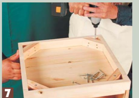
7 台輪に強度をつけるため、木工用ボンドとインパクトドライバーで四隅に火打ちを取り付ける。
