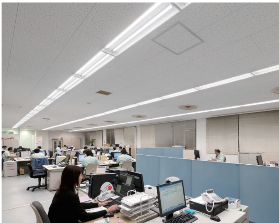
1階部分の照明器具を「直管形LEDランプ搭載ベースライト」に更新された本社事務所棟
