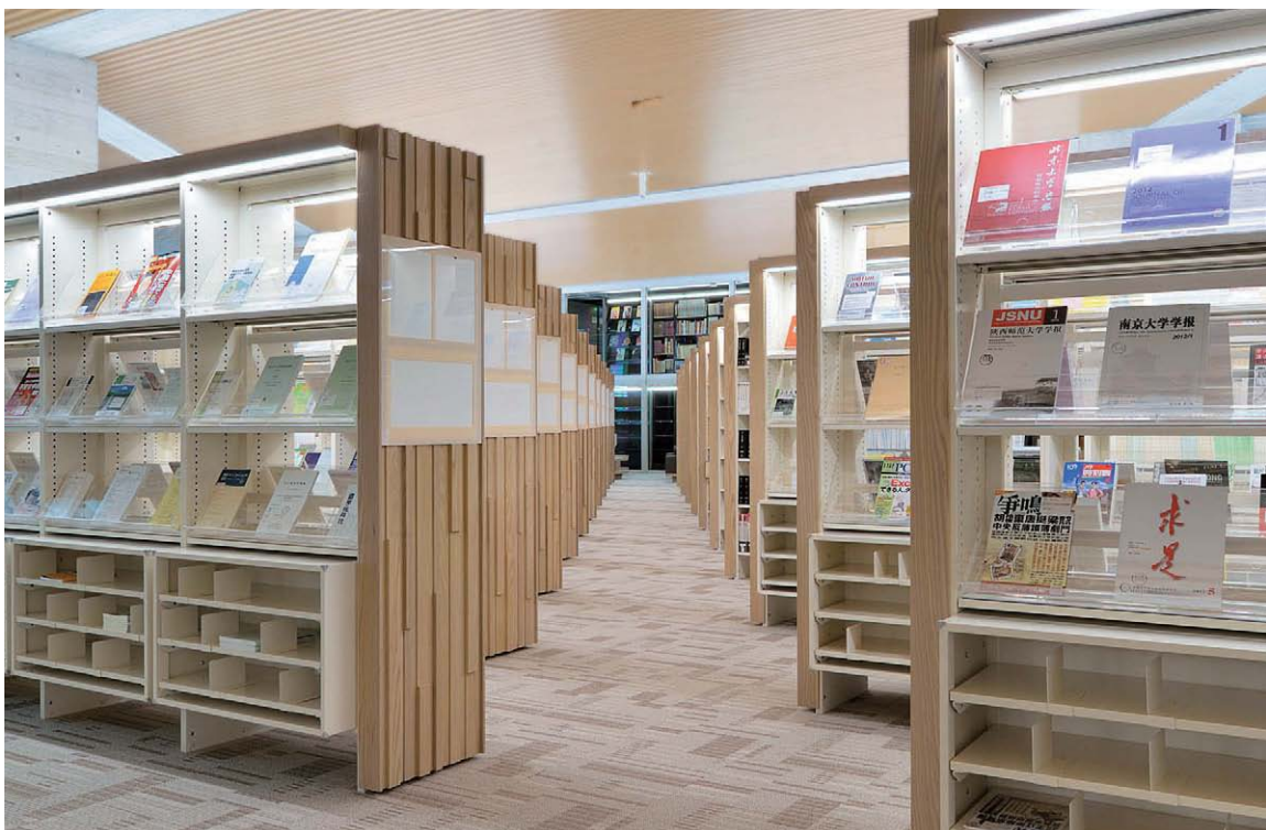
斜行グリッドにより、本が見やすく配置された書架は、30W シームレス蛍光管 (3500K) による本と通路を照らす下方向の光に加え、天井面を照らす照明も組み込まれ、天井照明がなくても明るさ感と広がりを感じられる空間になっている。
