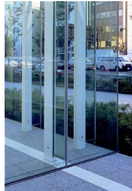
1階エントランスホール端部詳細。プラザとの連続が意識され、床仕上げが連続する。
