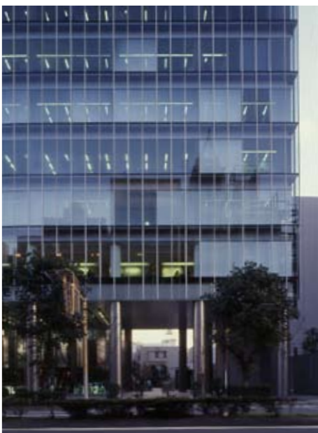
1階は高さ8mのピロティになっており、視線が南北方向に抜ける。撮影：本誌写真部
