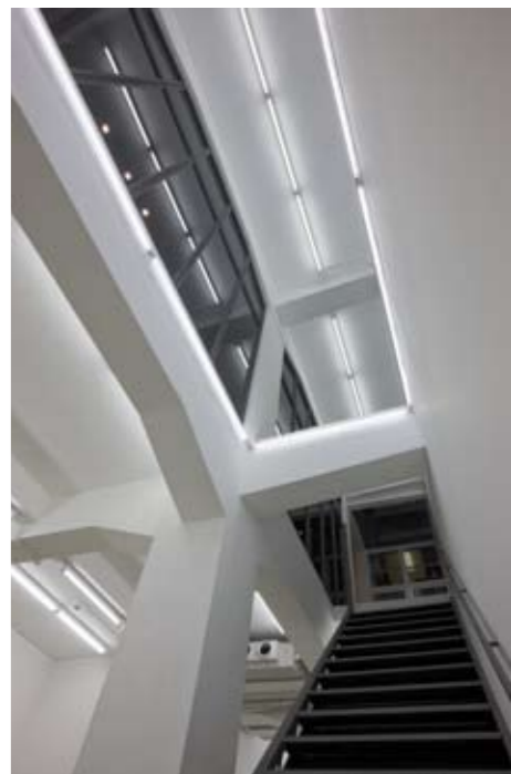
階段の吹き抜けを見上げる。吹き抜けに沿って、ここだけ細い蛍光灯が配置されている(竣工時)。
