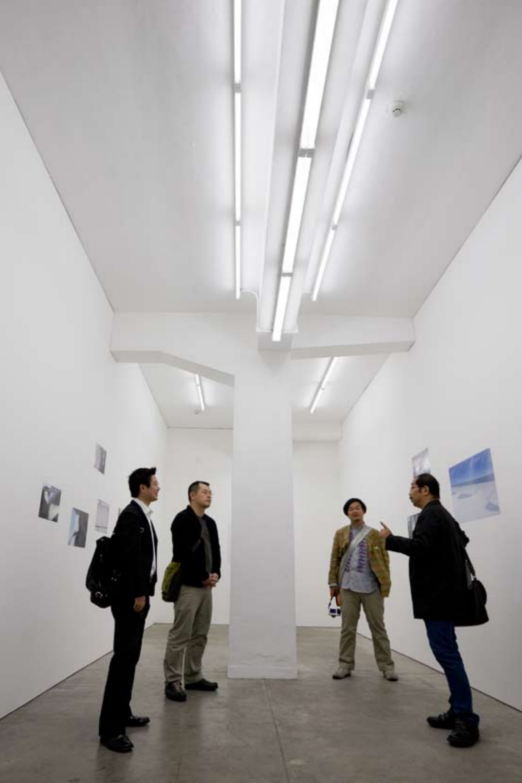
地下1階ギャラリーで青木氏の説明を聞く。壁面に梁や自身の影が落ちず、明るさが一定になるように蛍光灯はすらして配置されている。柱、梁、壁、床は既存を活かし、その上に塗装で仕上げている。壁面は片山博文氏の作品。 撮影：新建築社写真部 26～28頁写真のみ：courtesy of TARO NASU
