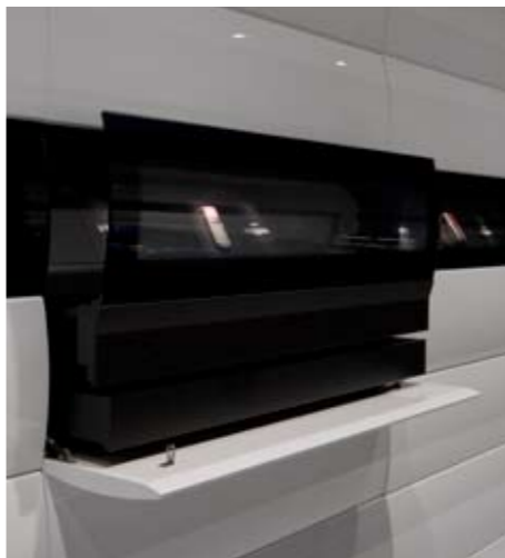
フィーチャーウォールは非接触型のカードによって開閉され、表からは金具が見えないようになっている。照明は個別に点灯でき、商品が展示されていない部分の照明は消されている。
