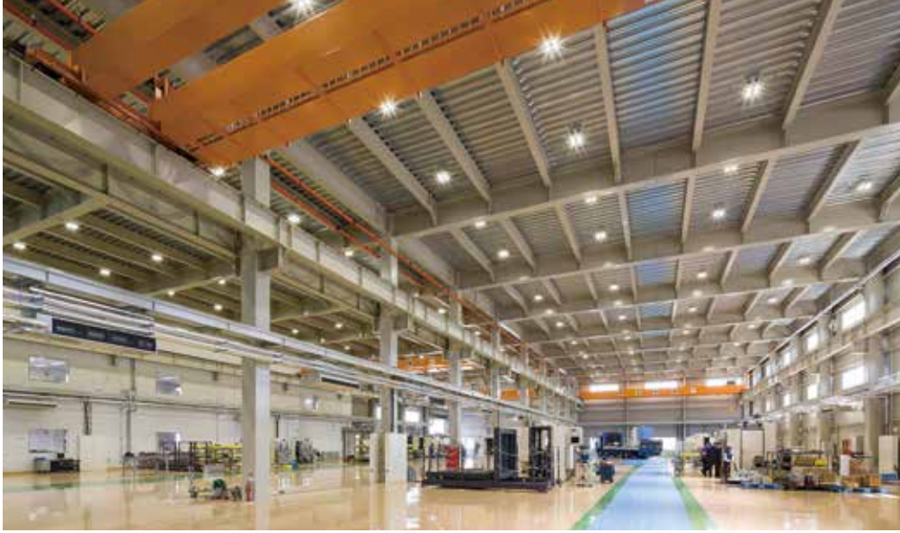
約11mの高さがある工場棟1階に設置された、「EVERLEDS高天井用LEDダウンライト2000形」。ワンコア(ひと粒)タイプで多重影が出ない点が評価された
