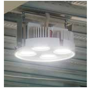
約11mの高さがある工場棟1階に設置された、「EVERLEDS高天井用LEDダウンライト2000形」。ワンコア(ひと粒)タイプで多重影が出ない点が評価された
