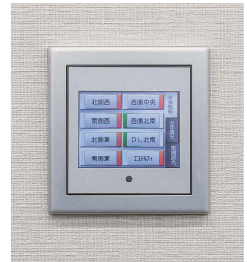
多数のLED照明をコントロールするフル2線液晶操作パネル
