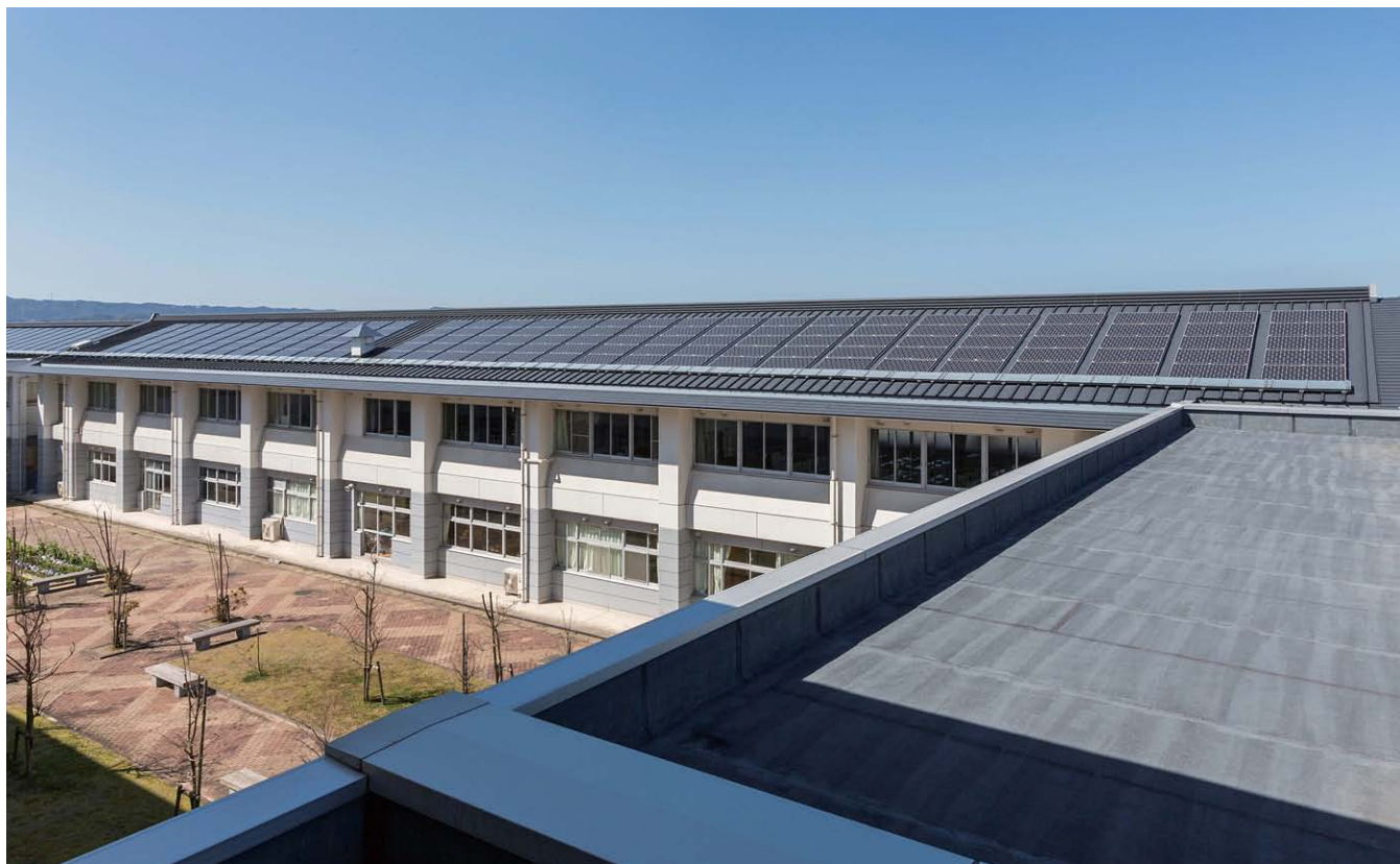
南向きの勾配屋根9箇所にHITモジュール1200枚を設置。
