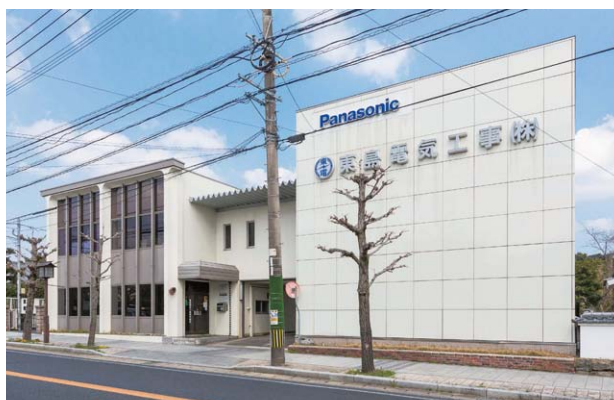
東島電気工事様本社社屋。こちらにも太陽光発電設備を設置。
