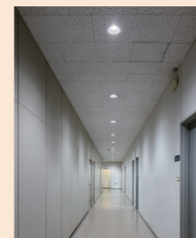
WiLIAのダウンライトが整然と並ぶ2階廊下。従業員の出勤時間に合わせて明るさをコントロールしています。
