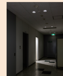
PiPit調光シリーズのダウンライトと受信機。PiPit調光は信号線工事が不要の省施工。受信機が人を検知します。
