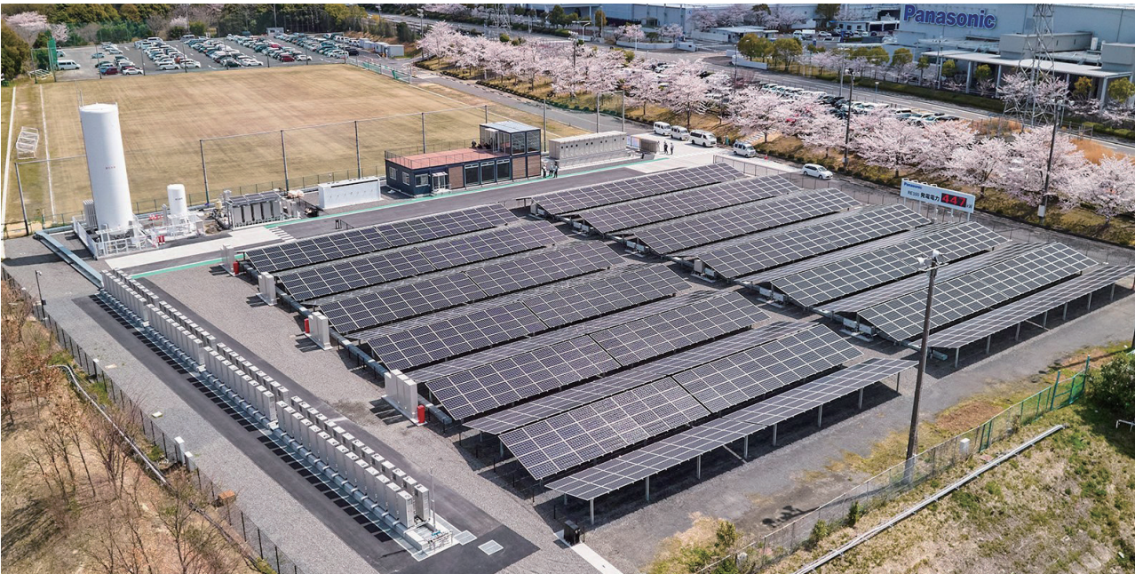
パナソニック環境エンジニアリング株式会社が設計・施工を手掛けたパナソニック株式会社の草津拠点にある「RE100ソリューション」実証施設「H2 KIBOU FIELD」。世界初の純水素型燃料電池・太陽電池・蓄電池の3電池から成る。
