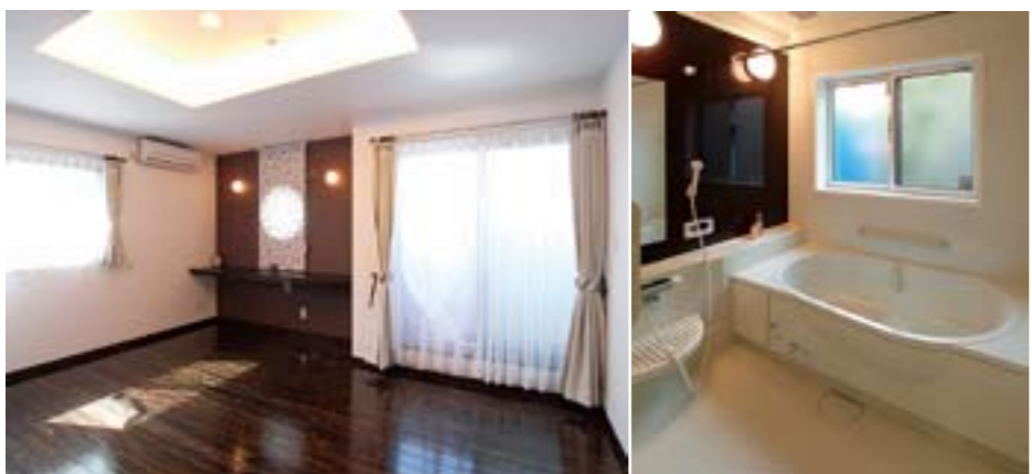
寝室。床には県産材のスギに天然塗料をコーティングして高級感を演出。
