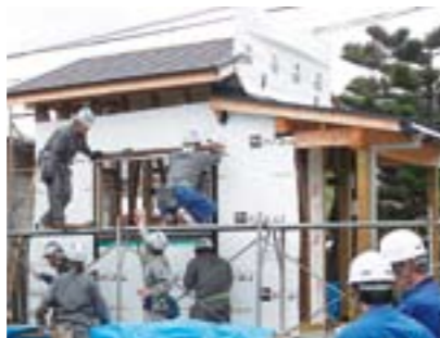
本社敷地内にある実習棟で、社内はもとより職人も施工の実地研修で技術向上を目指す。
