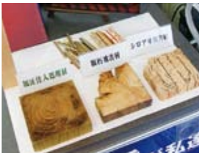
シロアリで腐朽した木材を実際に展示して防蟻工事保証を詳しく説明。
