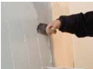
<下塗り> 下から上、次に縦、横と、こすりつけるように塗り重ねる。
