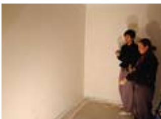
<完成・確認> 壁にライトを当て、兄の健春さんと表面の凹凸をチェックする美幸さん。
