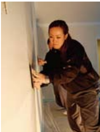
<下塗り> 下から上、次に縦、横と、こすりつけるように塗り重ねる。
