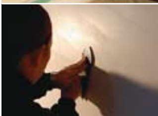
<仕上げ(上)塗り> 写真上／下塗りより1.5mmほど厚く重ねる。鏝に全身の力を込めて壁を押し付ける。写真中／指先の感覚を頼りに、壁の厚さが均一になるように仕上げる。写真下／磨き抜かれた白壁の表面は顔料が写るほどのツヤが出る。
