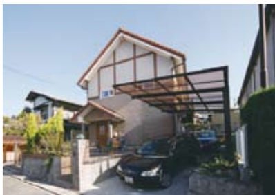
開口部を最小限にした西側壁面は化粧梁がアクセントに。
