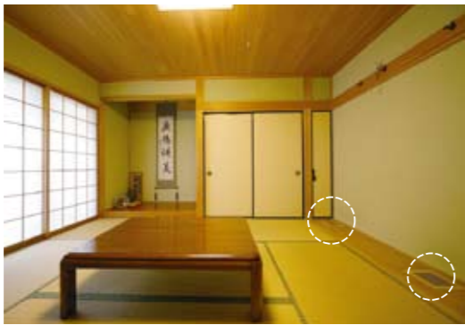
和室(8畳)は、板張り部分に換気・空調用の空気吹き出し口を設置している。
