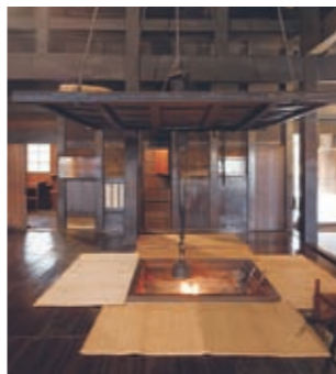
大火棚の上は土壁で塗り固められており、上に薬ぐつなどを上げて乾燥させた。
