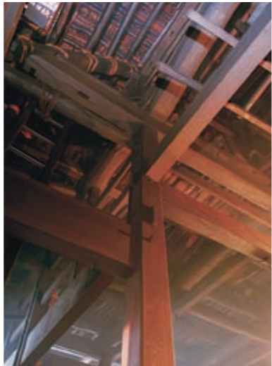
主屋で一番太い炉地の8寸角(約24cm)の太柱。小屋組と太い上屋柱、梁などと組み、屋根裏の大梁構を支えている。
