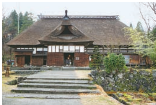
正面外観。主屋は約12m。正面の屋根の庇は雪対策のため約1mもの厚さがある。
