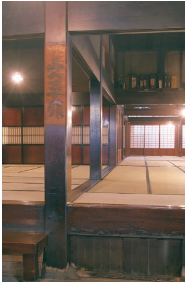
桁行16間、梁間6間の大空間を支える柱は柱間と荷重により、4寸～8寸角(約12～24cm)の柱が配されている。(手前が8寸角、奥の座敷側が6～7寸角)
