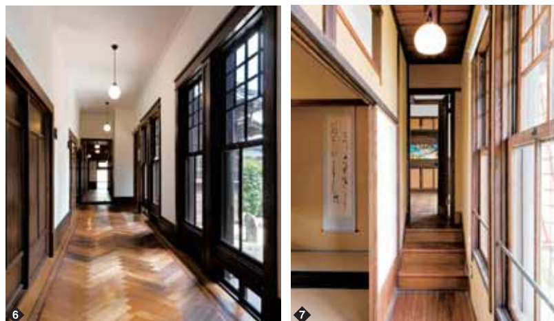
6 洋館から和館へ延びる廊下。左は和室だが、建具の廊下側を洋風にすることでデザインの調和を図っている 7 この外観は洋風であるため、窓と和室の間に縁側を設けて緩衝帯とし、双方の趣が生きるように工夫した。奥に洋風の書斎が見える
