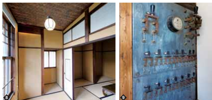
8 創建当初の姿を残す2階仏間。網代天井は屋久島から取り寄せた屋久杉で作られた 9 創建当初の配電盤。自家発電装置も備えていた貞奴邸は停電知らずだったという
