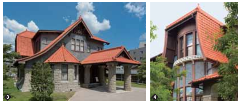
3 4本柱の車寄せや、扇垂木形式の円すい屋根が目を引く正面玄関。2階外壁は色モルタルを掃き付けたドイツ壁。マンサードと切妻を組み合わせたユニークな屋根。マンサード屋根は、多様な様式の屋根、壁を組み合わせた装飾性の高さの特徴がある。大正9年頃の外観写真による推定復元 4 マンサードと切妻を組み合わせたユニークな屋根。マンサード屋根は、当時のあめりか屋軽井沢出張所の建物にも用いられた
