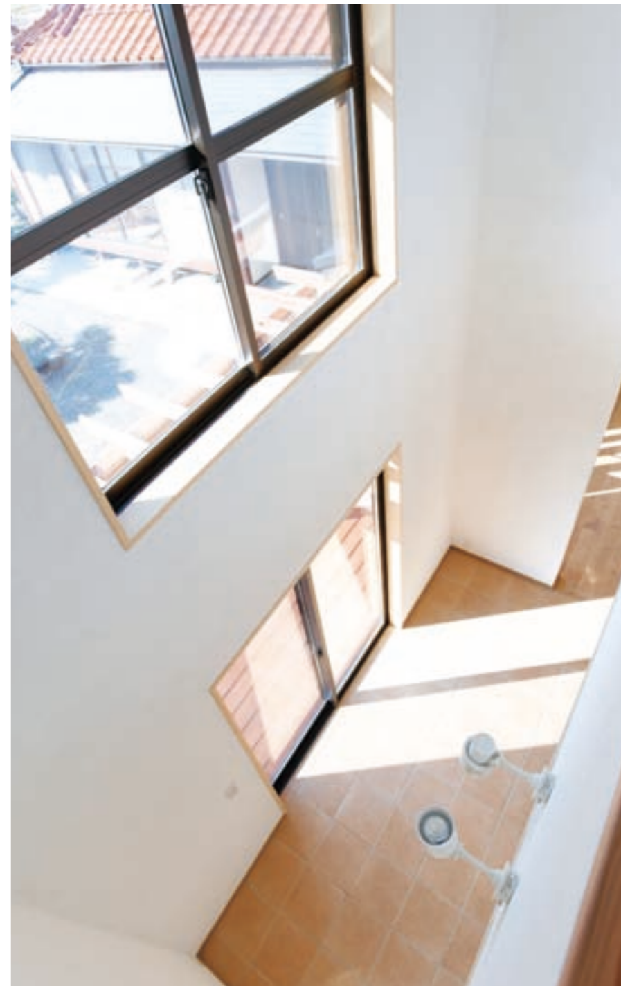
冬には日差しがインナーテラスの蓄熱体を暖め、吹き抜けを介して暖気が2階に届く
