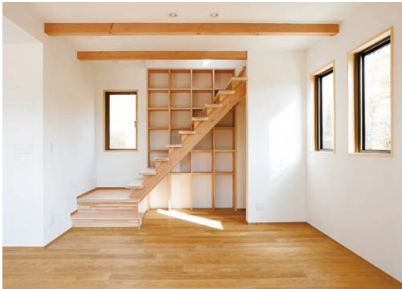
さまざまな種類の無垢材を利用し、天井はあらかしとしたインテリア
