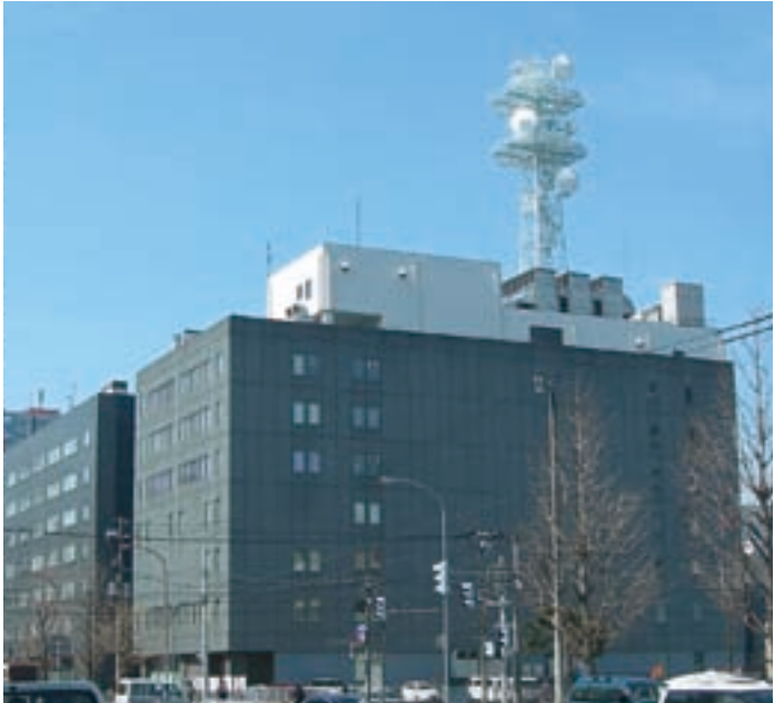
白に近いうすいブルーで空に溶け込むようにした、北海道電力本店電波塔 ©宮内博実
