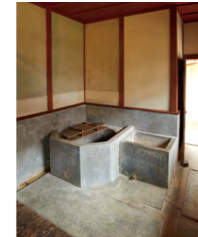
風呂場。床は余熱で温められる仕組み
