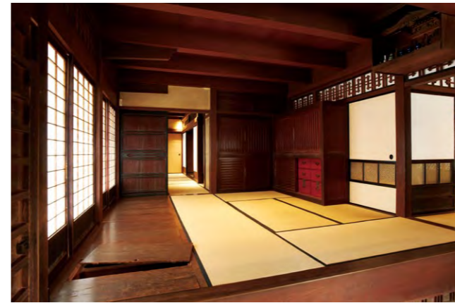
主屋の店の間。涼しい床下に蠟を保管するスペースが設けてある
